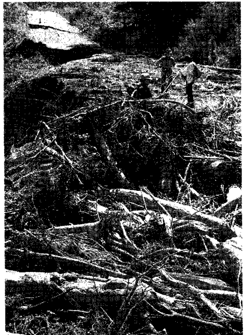
ズタズタに寸断された「平取・新冠区間」 台風以前から崩壊していたところもある
